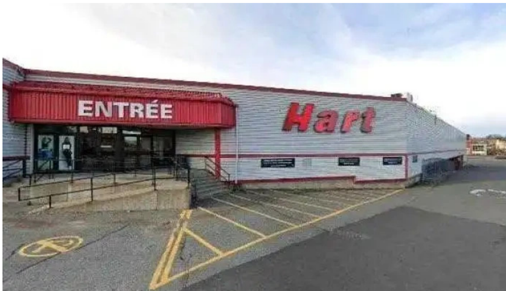
Bureau en gros street view 360
